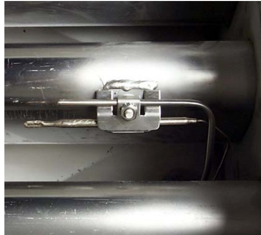
Τυπικές θέσεις αισθητήρων υψηλού ορίου/ αισθητήρα και υλικό τοποθέτησης.
